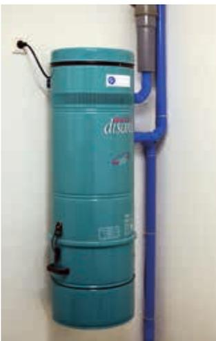
Die Zentraleinheit, der eigentliche Staubsauger, hängt im Technikraum – dort wo er niemanden stört. Ihr Vorteil: Die Abluft wird entweder in diesen Raum oder nach außen geleitet. Ihre Wohnräume bleiben von der Abluft und den Geräuschemissionen des Staubsaugers verschont.
